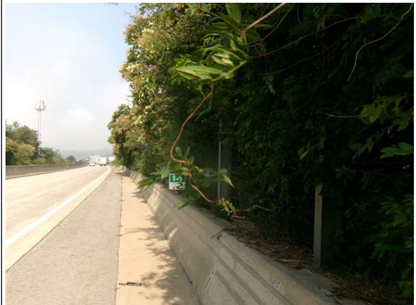
하부, 도로 전경
