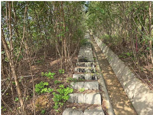
산마루측구, 점검계단 전경
