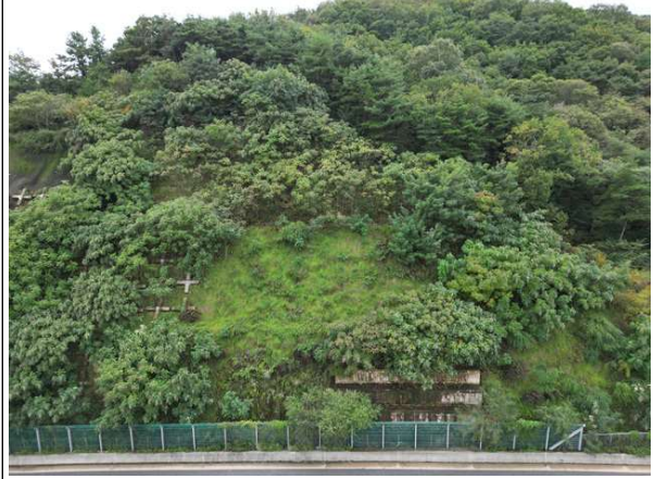
사면내 옹벽 전경
