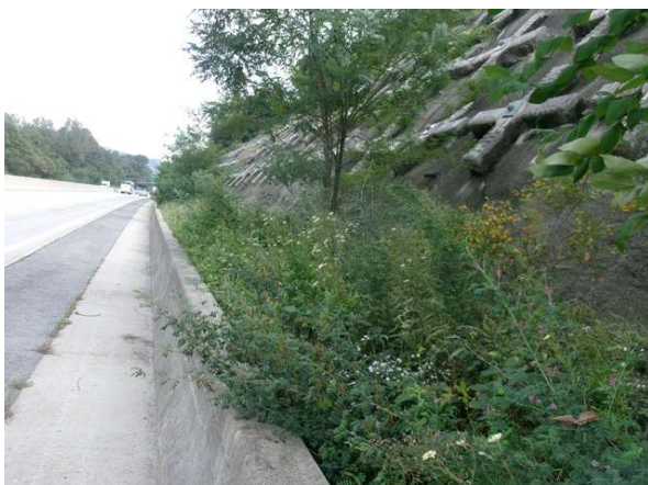
하부, 도로부 전경
