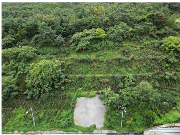
숏크리트 보호공 전경
