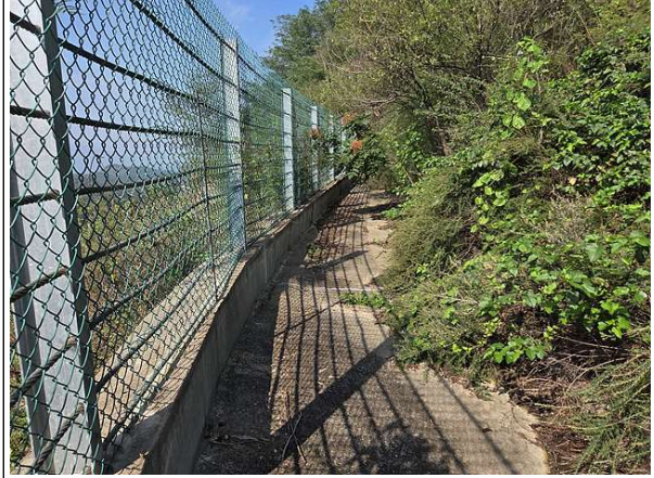
2소단 배수로 전경
