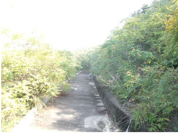
1소단 배수로 전경
