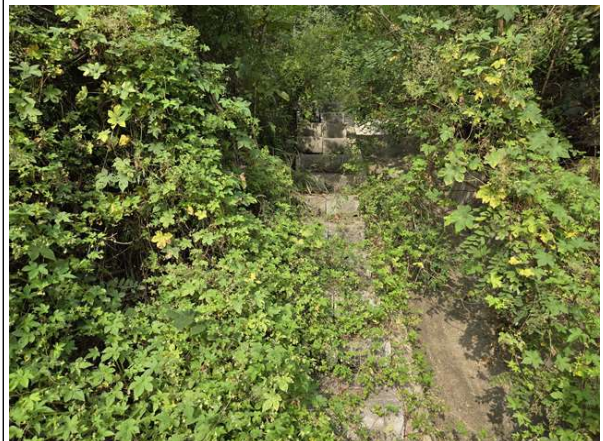
산마루측구, 점검계단 전경
