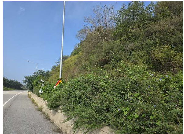
도로부, 낙석방지울타리 전경
