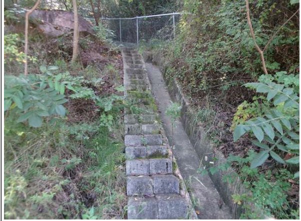
산마루측구, 점검계단 전경
