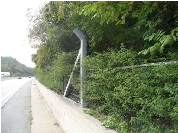
하부, 낙석방지울타리 전경
