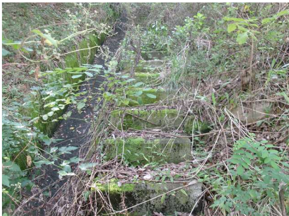
산마루측구, 점점계단 전경
