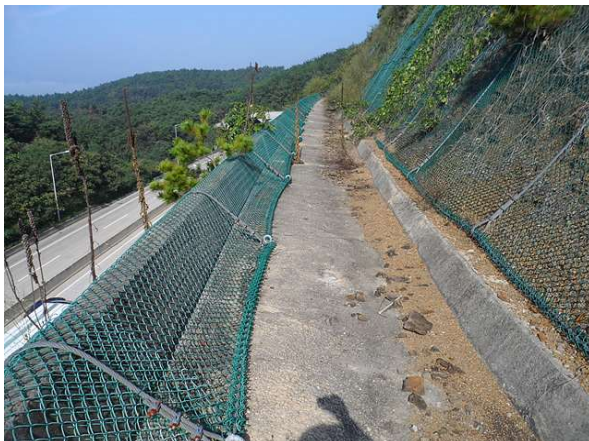
2소단 배수로 전경
