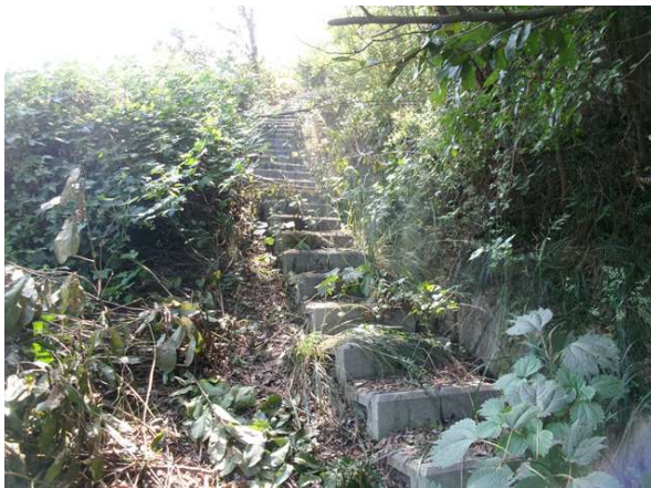
점점계단, 산마루측구 전경
