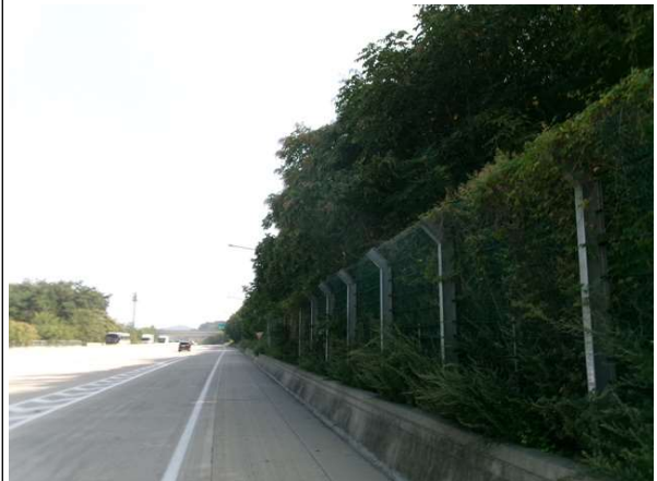
낙석방지울타리, 도로부 전경
