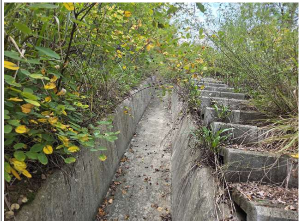
산마루측구, 점검계단 전경
