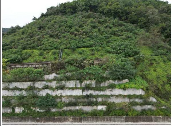
사면내 옹벽 전경
