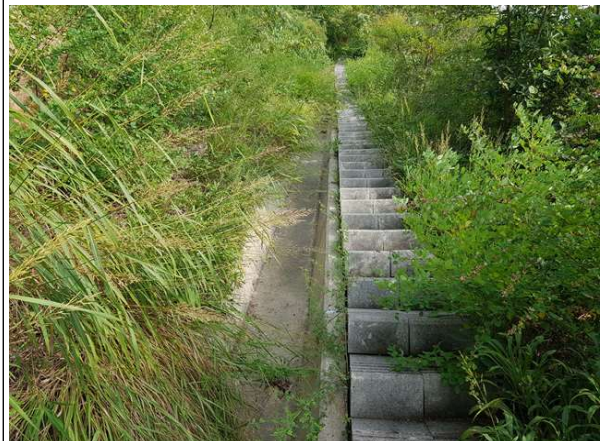
산마루측구, 점검계단 전경
