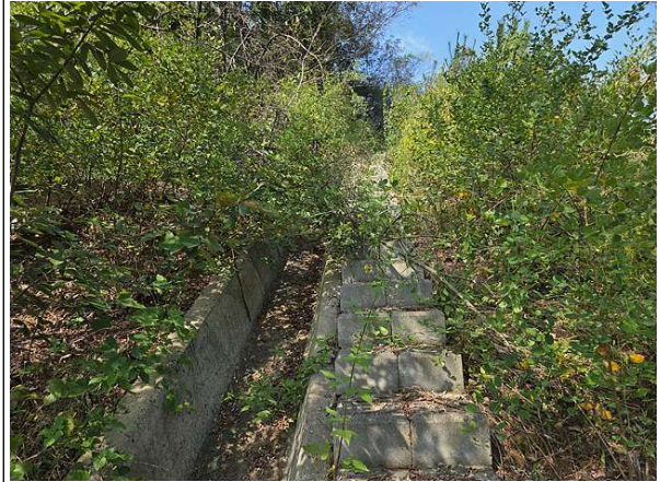
산마루측구, 점검계단 전경
