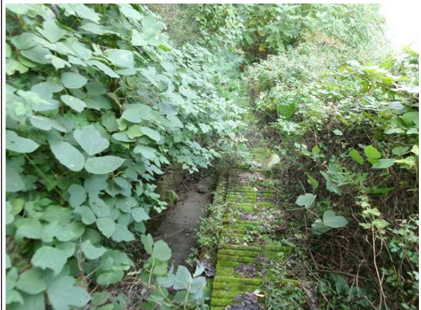
산마루측구, 점검계단 전경
