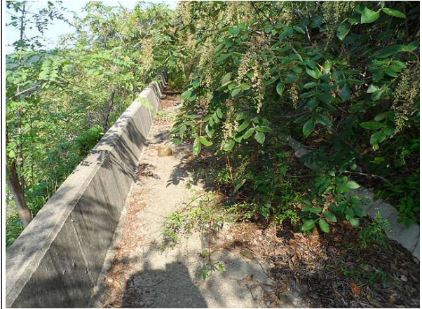
1소단 배수로 전경
