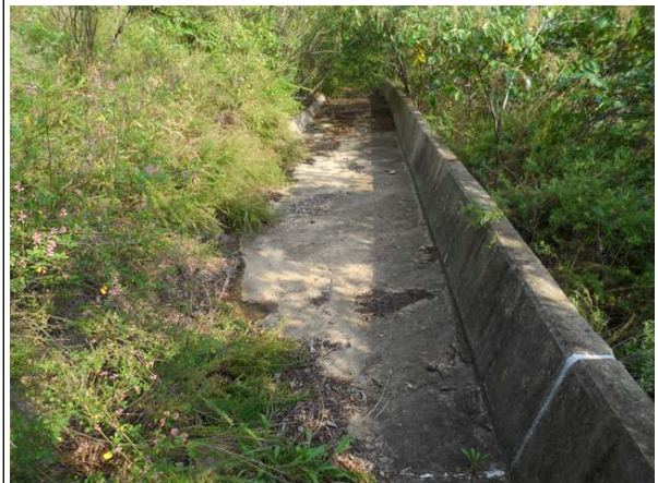
1소단 배수로 전경
