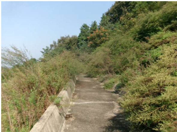
1소단 배수로 전경
