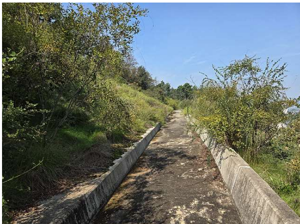
1소단 배수로 전경
