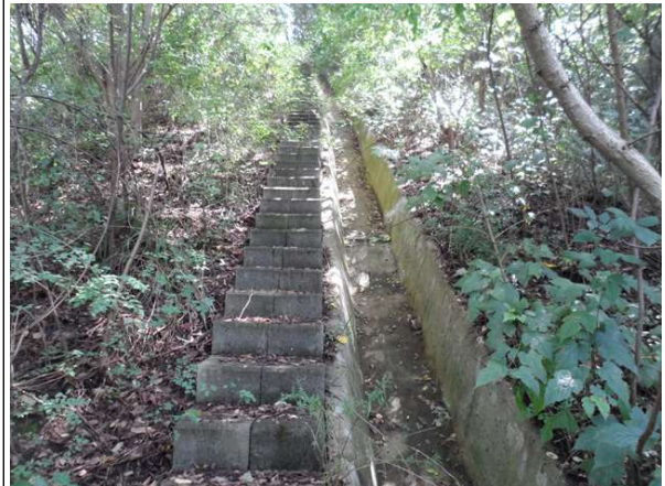
산마루측구, 점검계단 전경
