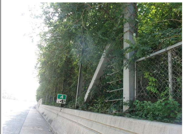
도로부, 낙석방지울타리 전경
