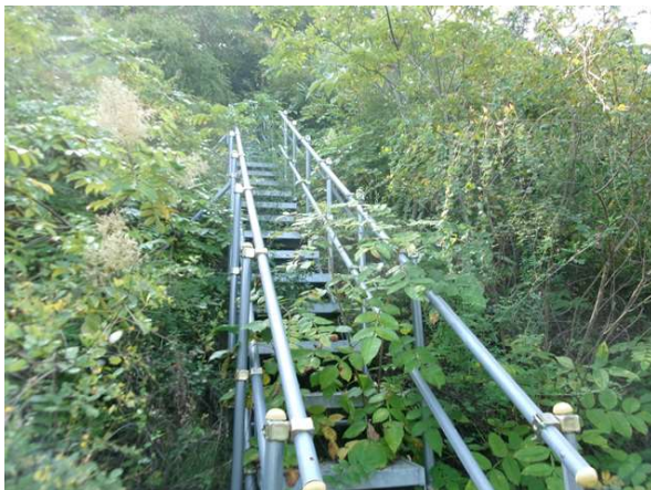
2단 점검계단 전경
