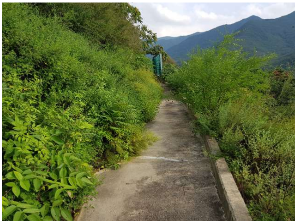
소단배수로, 낙석방지울타리 전경
