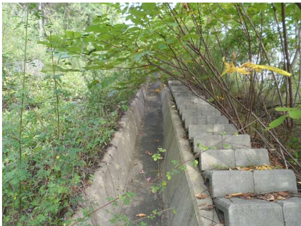
산마루측구, 점검계단 전경
