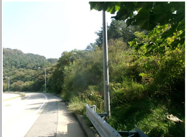
도로, 하단 전경
