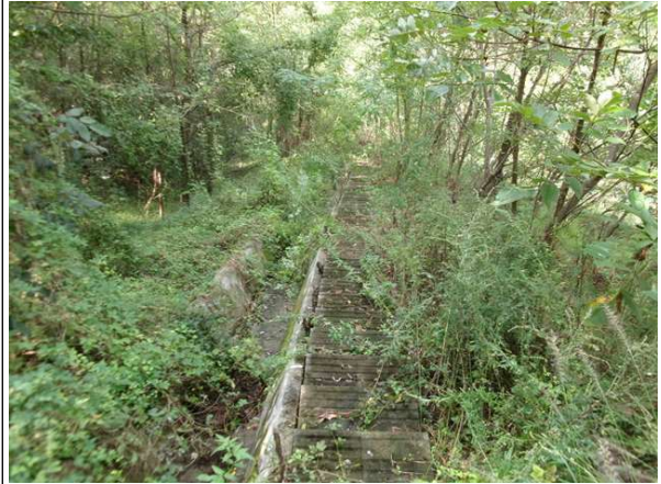
산마루측구, 점검계단 전경
