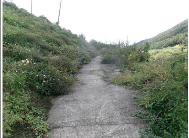
1소단 배수로 전경
