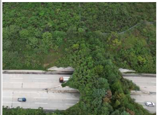
상태육교 상부 전경
