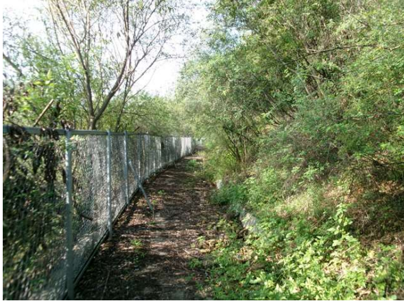
1소단 배수로 전경
