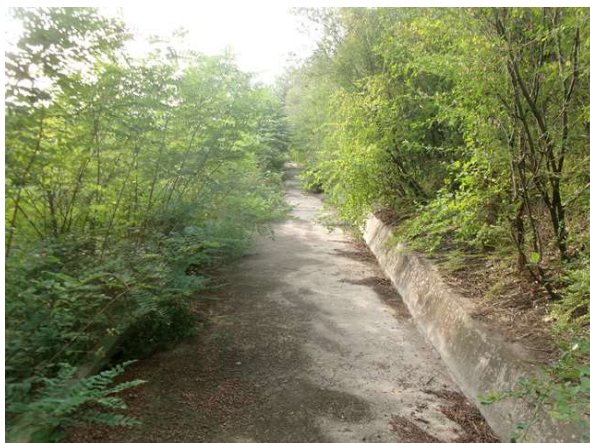
1소단 배수로 전경
