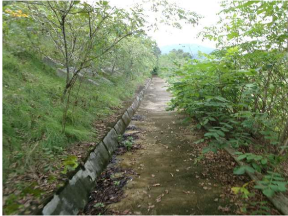
1소단 배수로 전경
