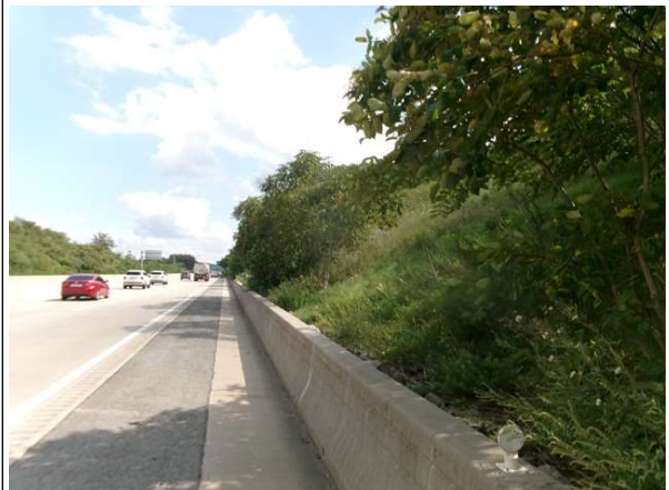
도로, 하부 전경
