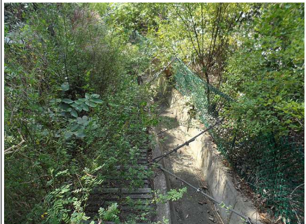
점점계단, 산마루측구 전경
