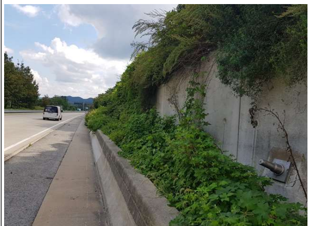
사면부, 하단 판넬형옹벽 전경
