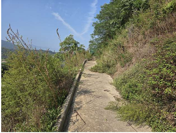
1소단 배수로 전경
