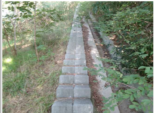
산마루측구, 점검계단 전경
