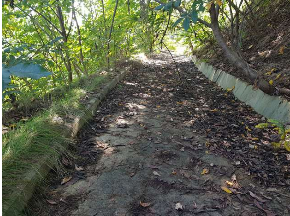
1소단 배수로 전경
